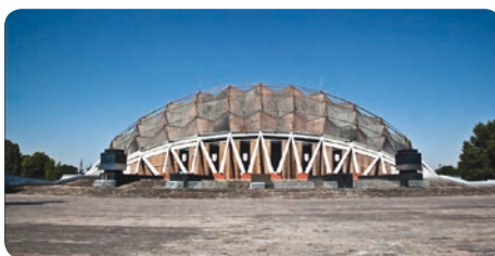
Fig. 2.36 El Palacio de los Deportes en la Ciudad de México es una estructura que fue construida para los Juegos Olímpicos de 1968. Su fachada exterior consta de una cúpula de cobre formada por cuadros que cubren un área aproximada de 6 7000 m 2 .
